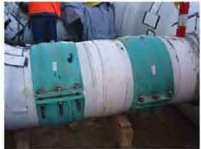
主管管接分支管处: 可连续设一至二台DOL，有效消除应力，方便更换管道及阀门，并可选择膨胀功能膨胀功能。
