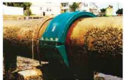
管道泄漏位置: 一旦大型管道出现泄漏，可使用抢修型DOL，只拧五颗螺丝，迅速消除管道破损带来的损失。
