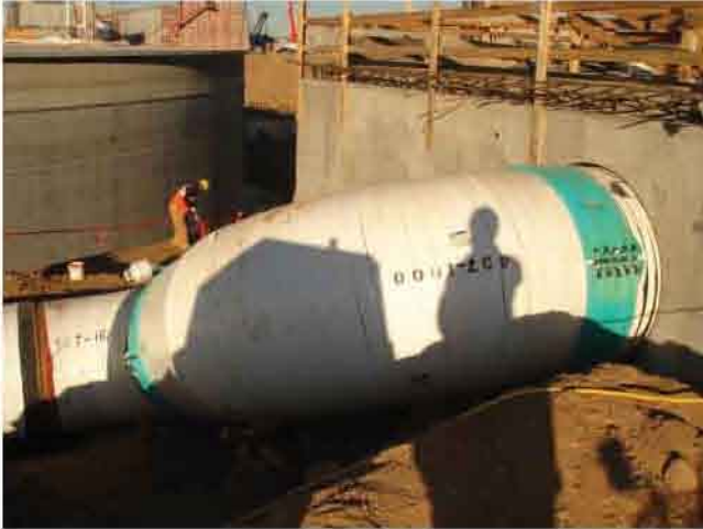
Z型防沉降安装: 用于水池、泵站等固定建筑的出入口，不需要制作大型管道防沉降基础，并可消除应力。
