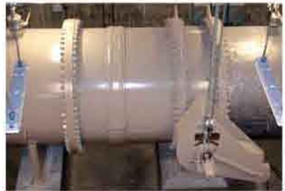
大型阀门及法兰处: 通过设置DOL法兰转换接头，可以提供管路膨胀与收缩的空间，易于安装及方便检修。
