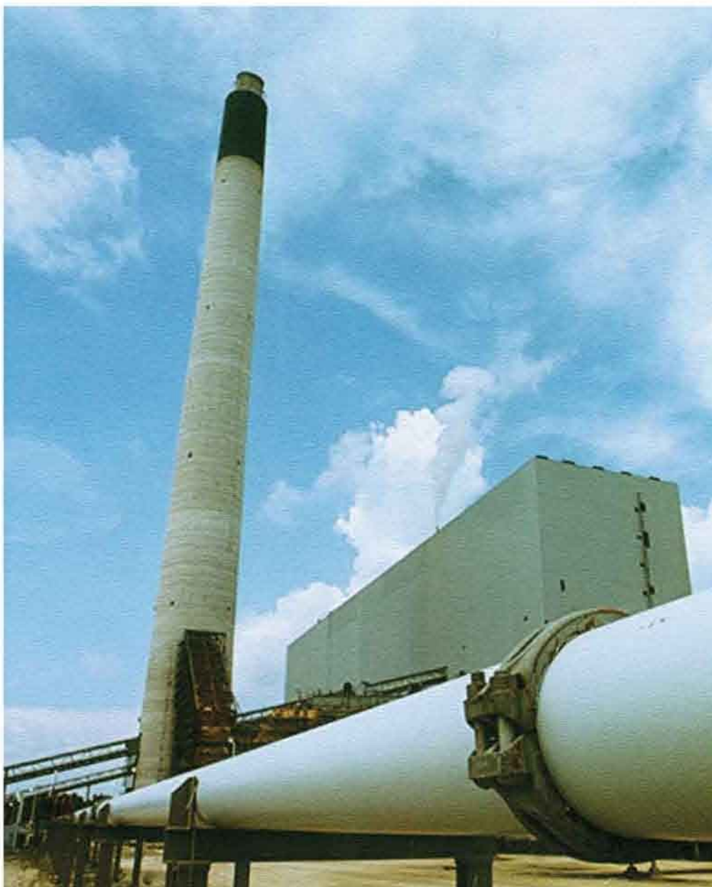
电厂膨胀V接系统
